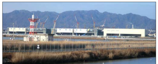
岩国基地では、住民の意図に反して格納庫の建設が進んでいる
